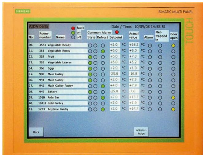
Die Temperaturanzeige der Gefrierräume. Das manuelle Auslesen der Temperaturwerte gehört jedoch der Vergangenheit an.
